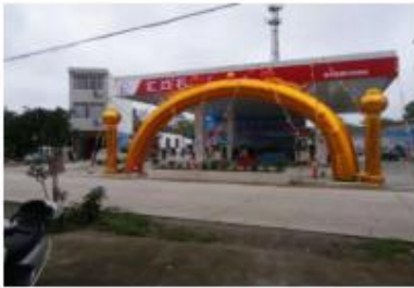
8. 1加油机全景照片
