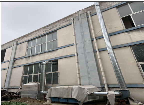
附图 5 项目现场照片
