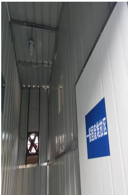
危废间排风扇
