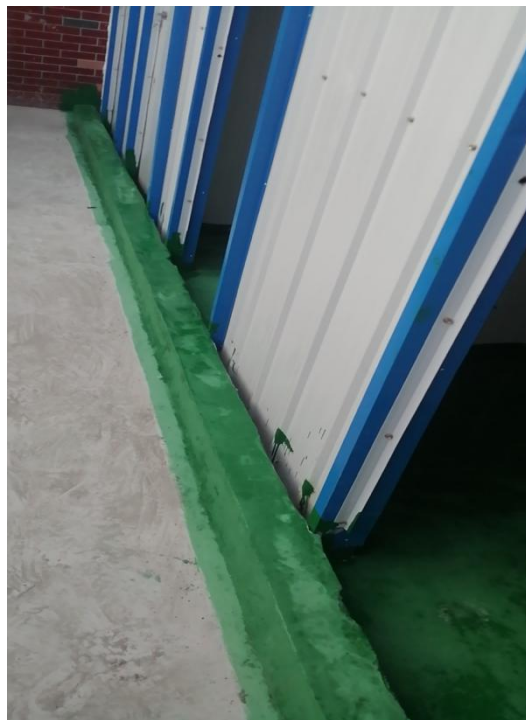
危废库门槛（防泄露措施）
