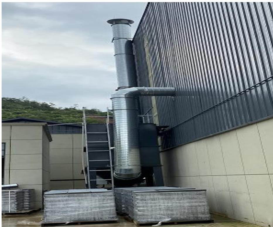
图 3-8 布袋除尘器、风管、1#排气筒
