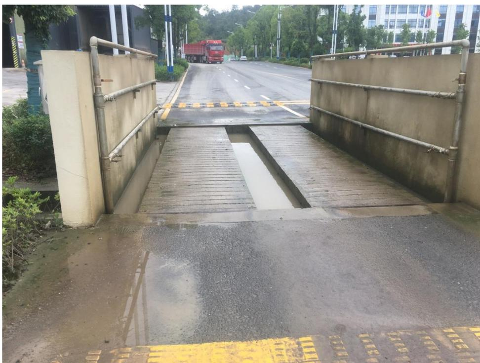
图 3-4 车辆冲洗设施照片
