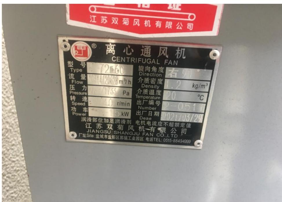
图 3-6 风机铭牌（投料工序粉尘）
