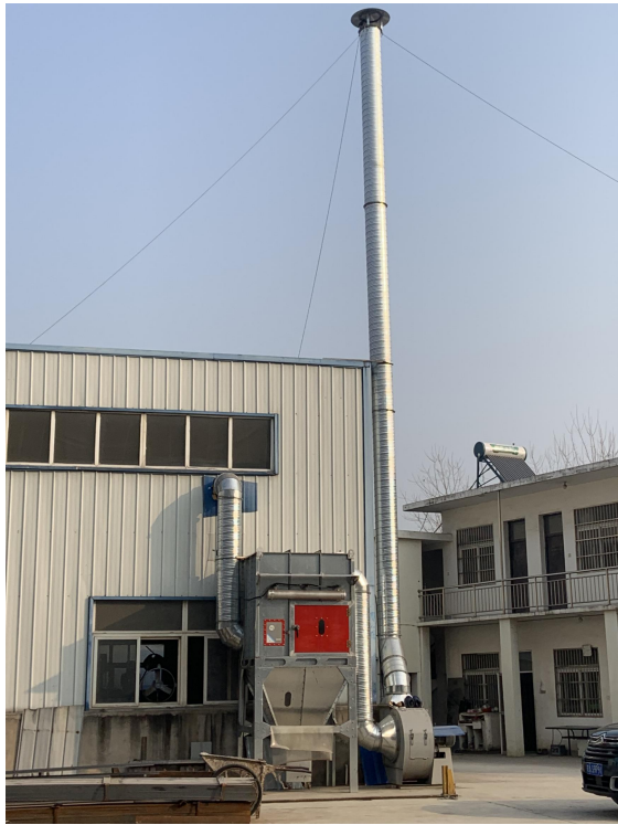
烟尘净化器+15m 高排气筒
