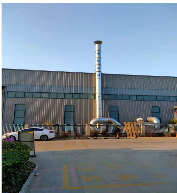
喷漆、烘干工序 15m 排气筒
