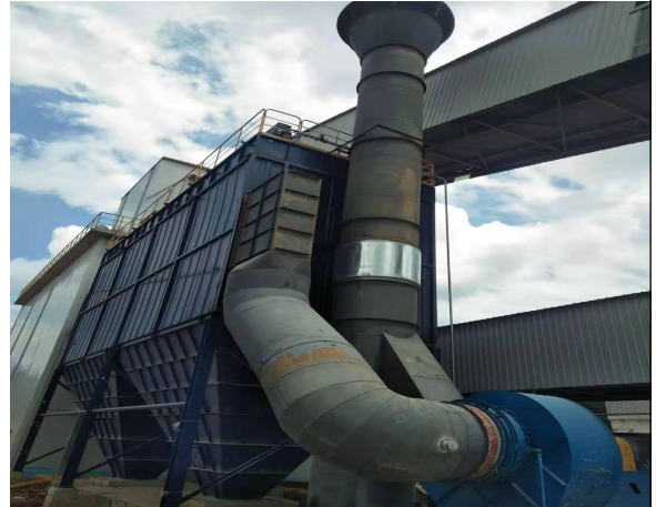
骨料筛分车间收尘废气处理：高效袋式除尘器+15m 高排气筒
